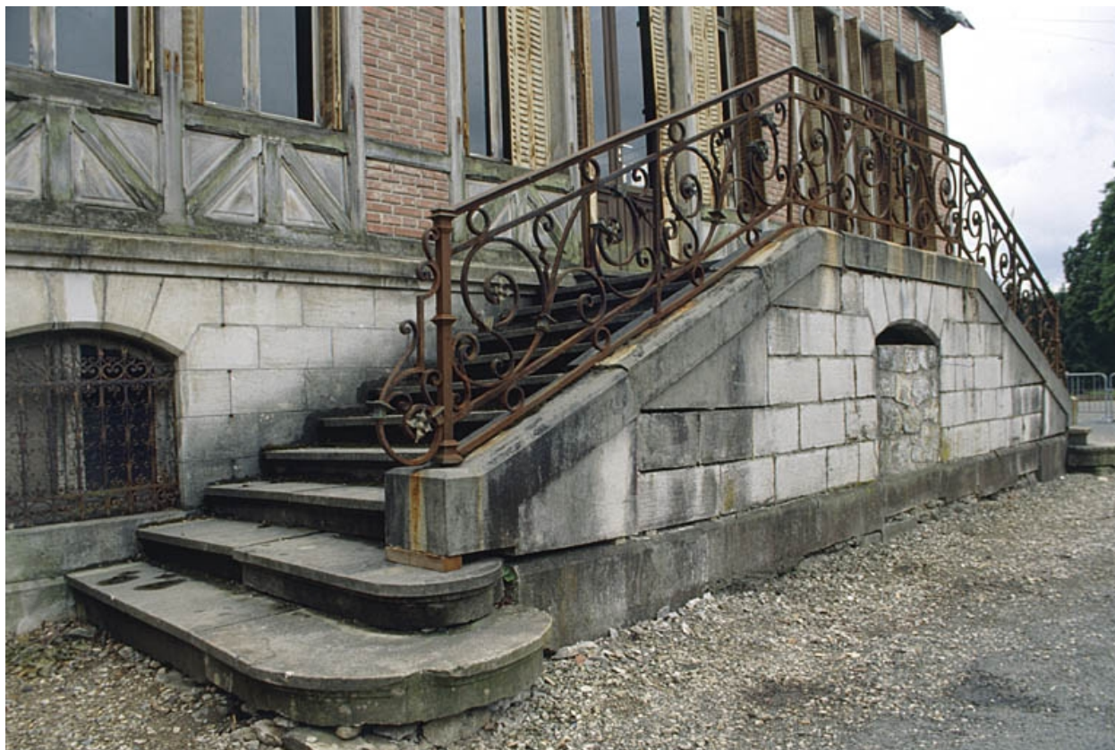
Détail de l'escalier de la façade postérieure.
