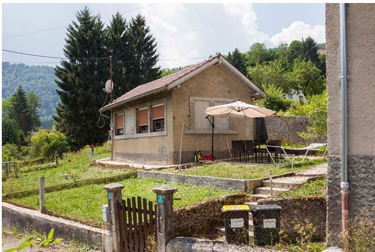
L'atelier de fabrication, depuis le nord-est.
