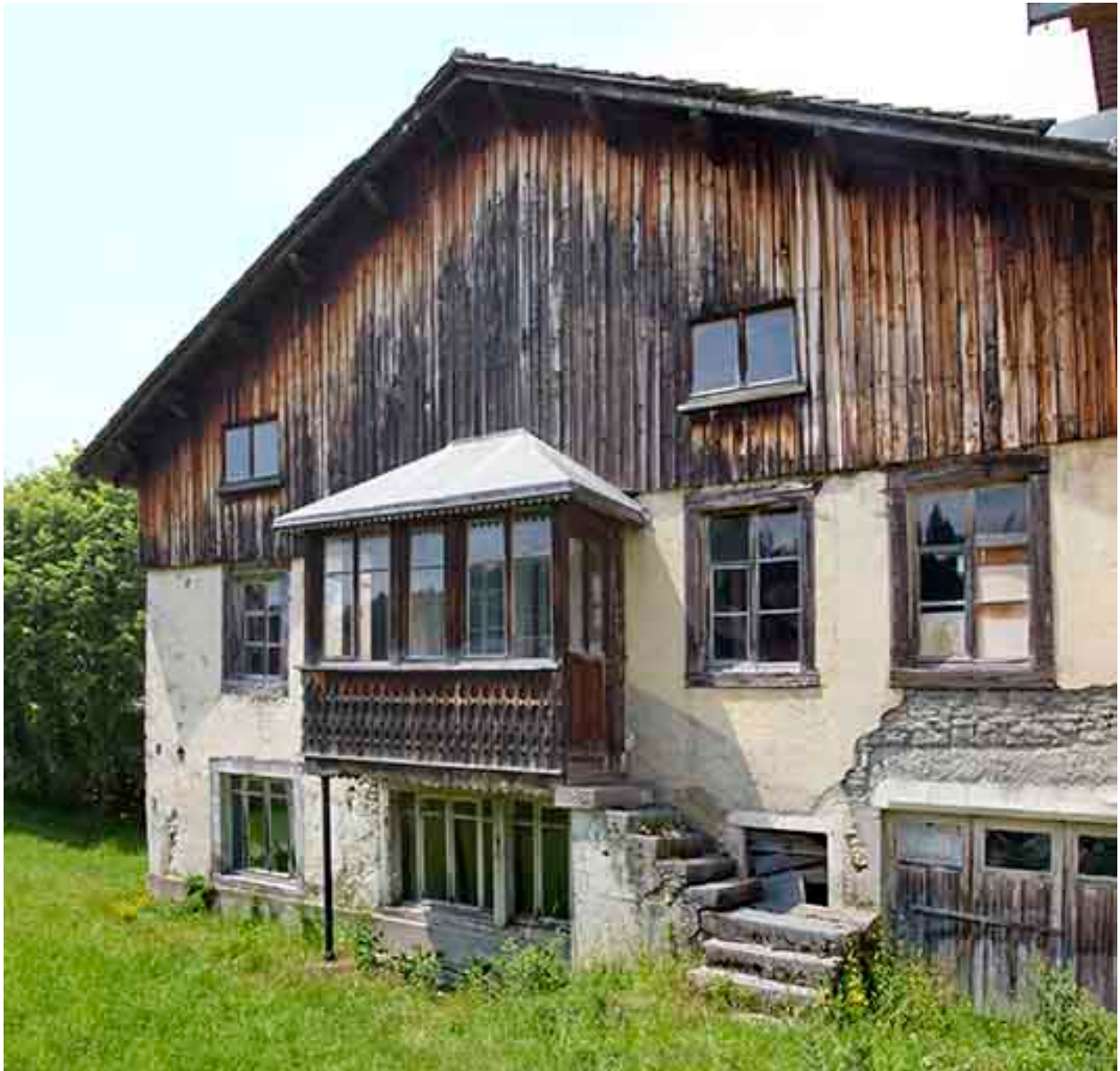
Logement d'ouvriers : façade antérieure.
