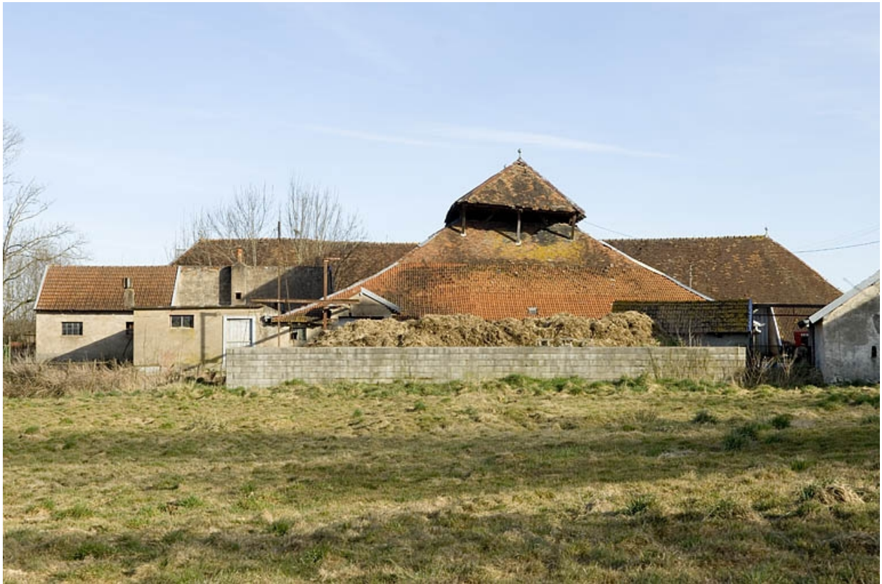
Bâtiment du four et séchoir depuis l'ouest.
