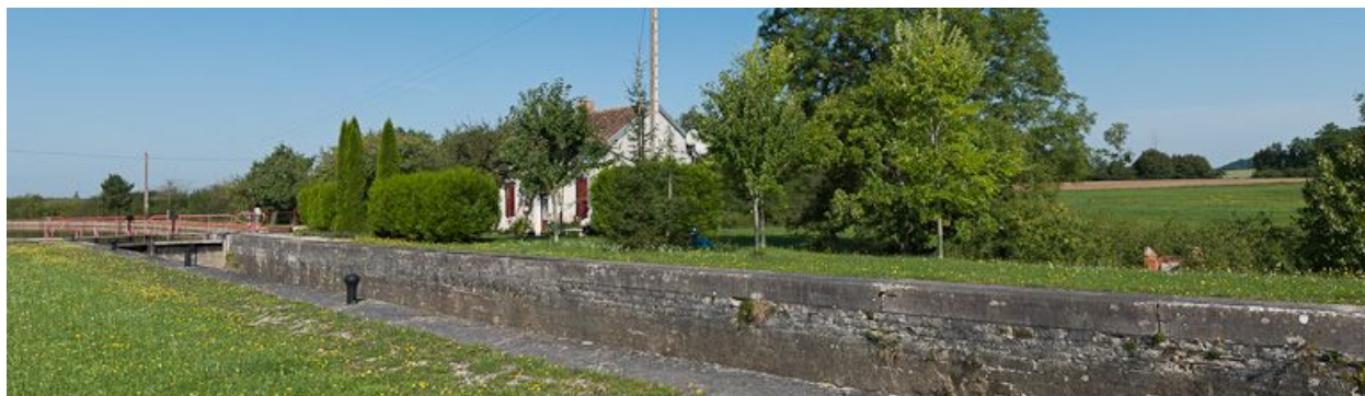
Vue d'ensemble du site d'écluse.
