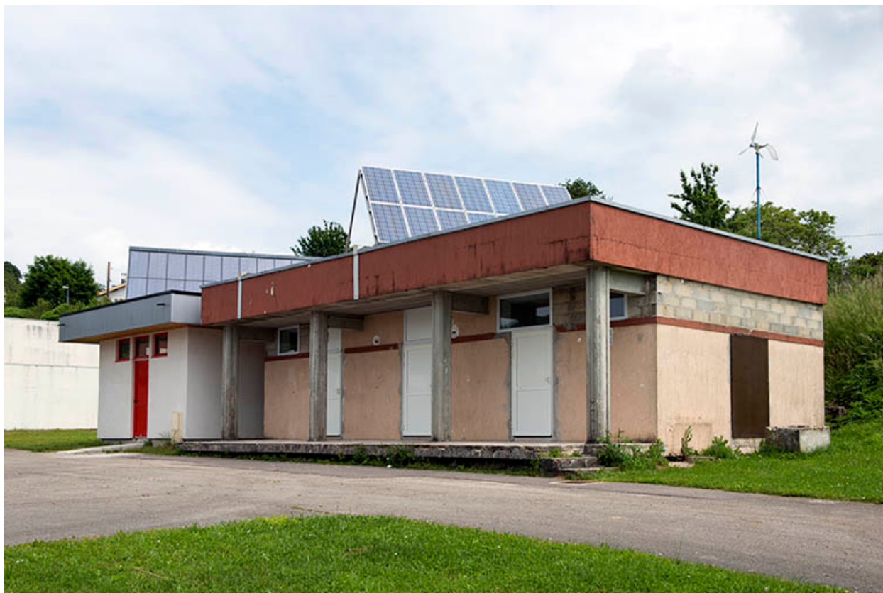
Face antérieure ouest du vestiaire.
