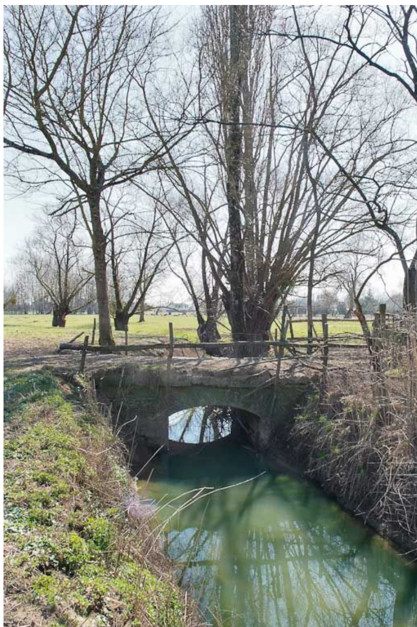
Ponceau : vue rapprochée.
