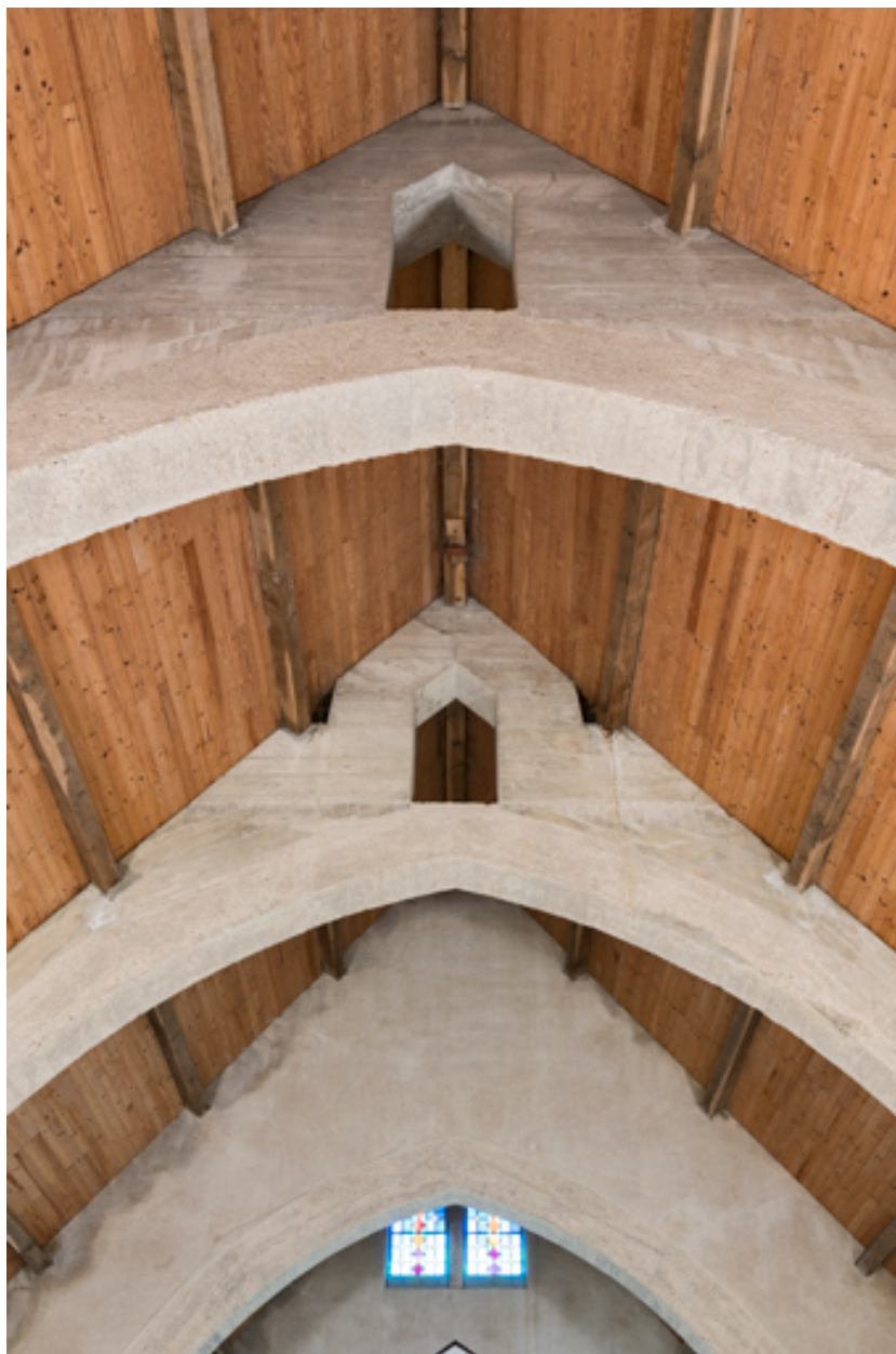
Charpente, détail des arcs.
