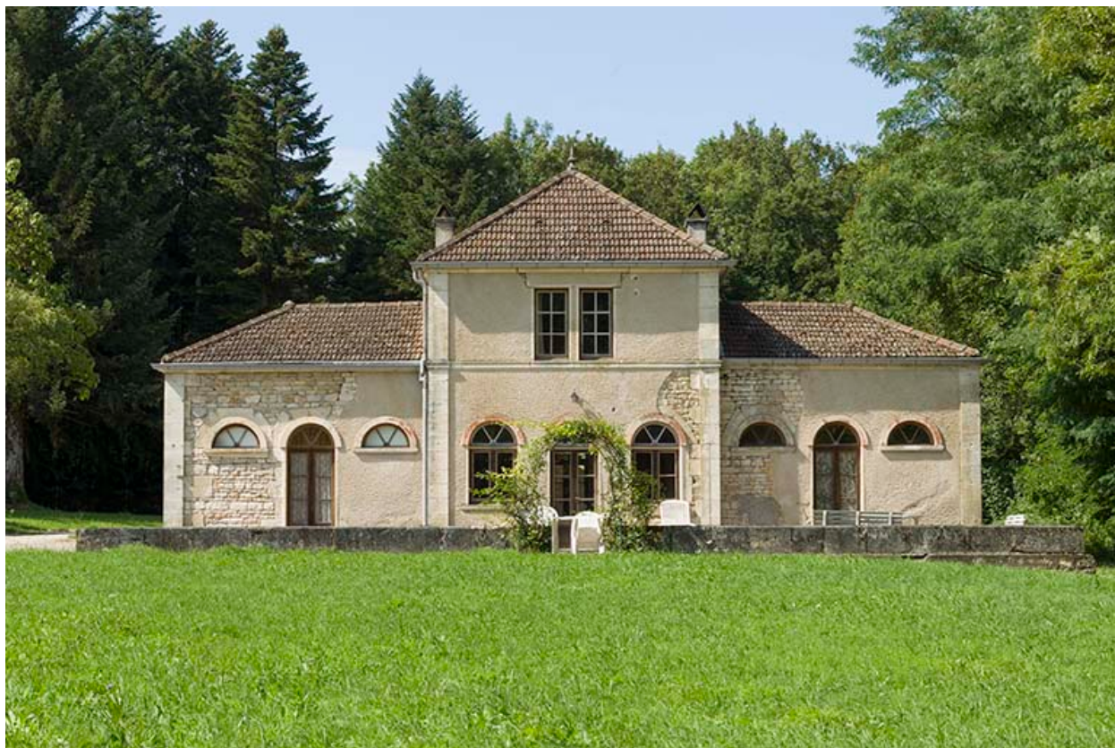
Façade antérieure du chenil.
