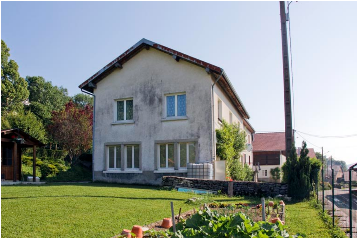
Façade latérale gauche de l'atelier.
