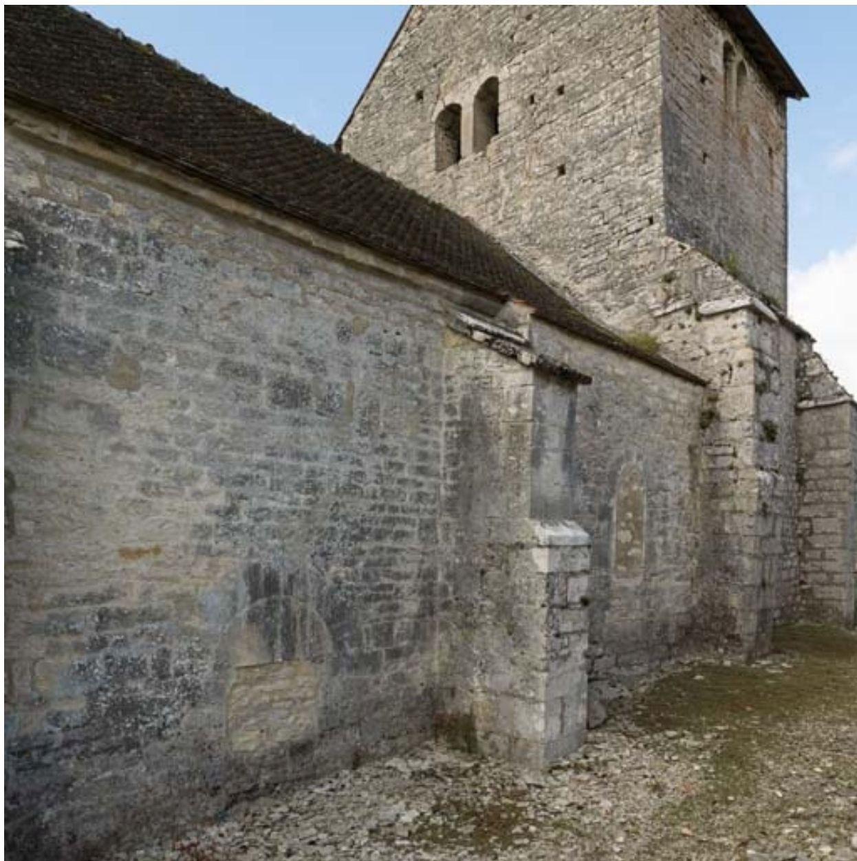
Détail des baies bouchées de l'élévation nord.
