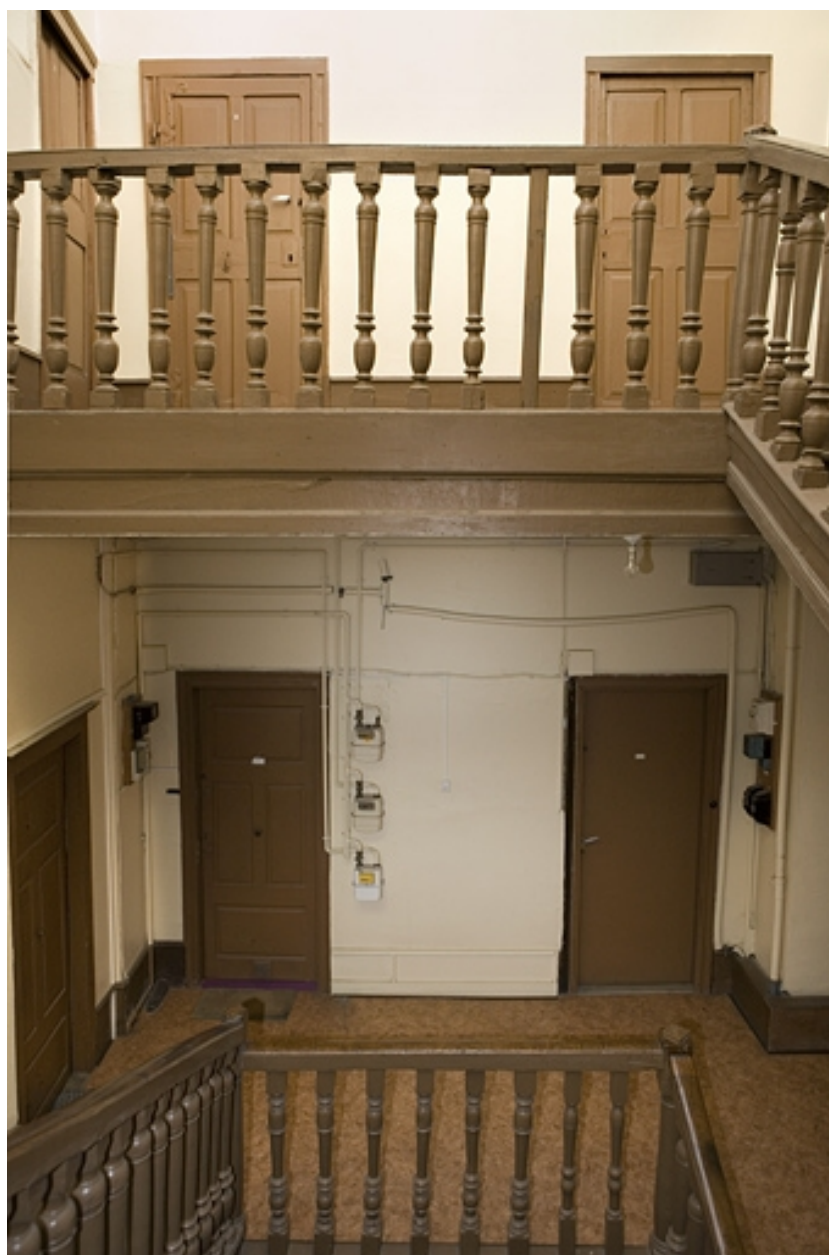
Détail de la rampe de l'escalier.
