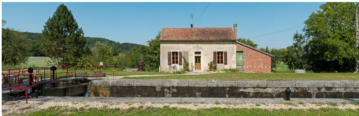
Vue de face de la maison éclusière.
