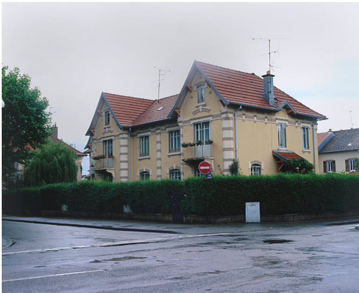
Logement double de contremaître rue d'Alsace.
