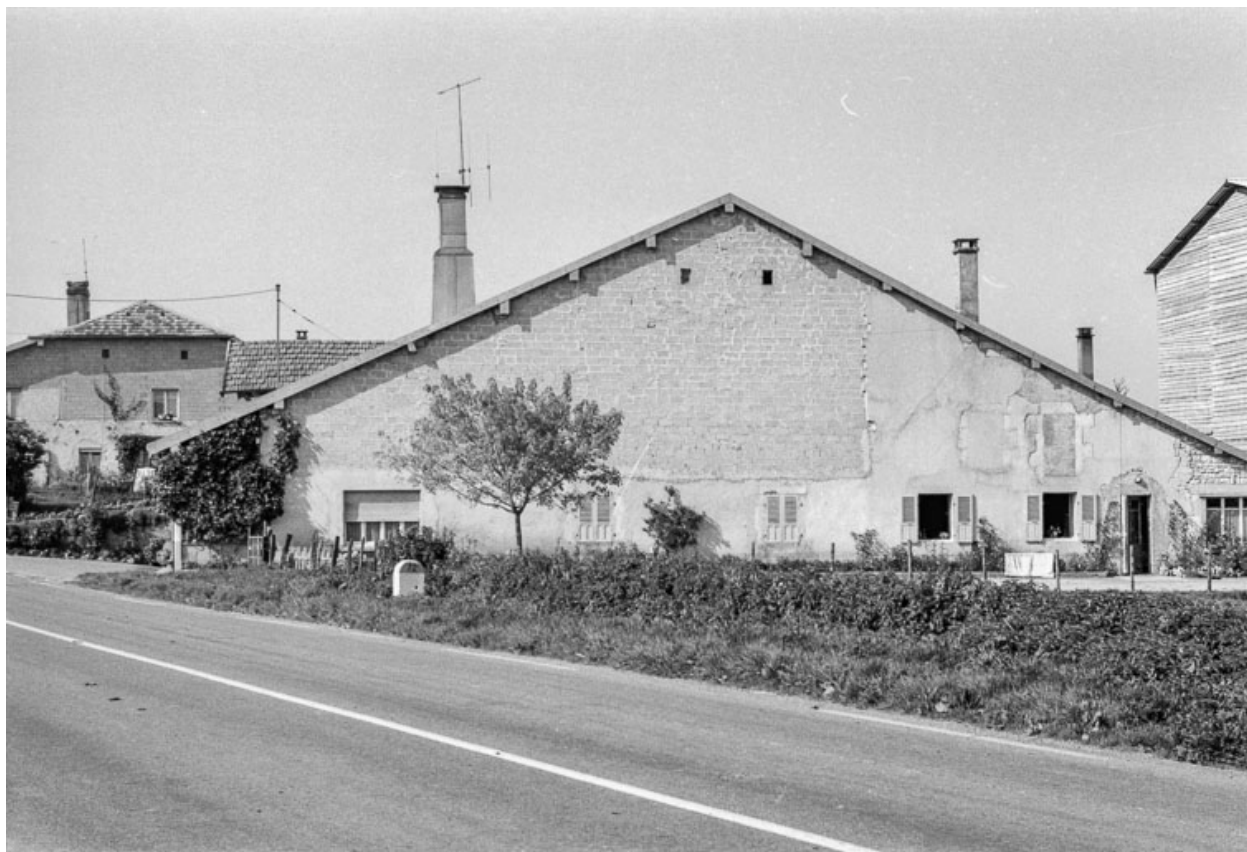
Ferme cadastrée 1961 AB 45 : façade antérieure.
