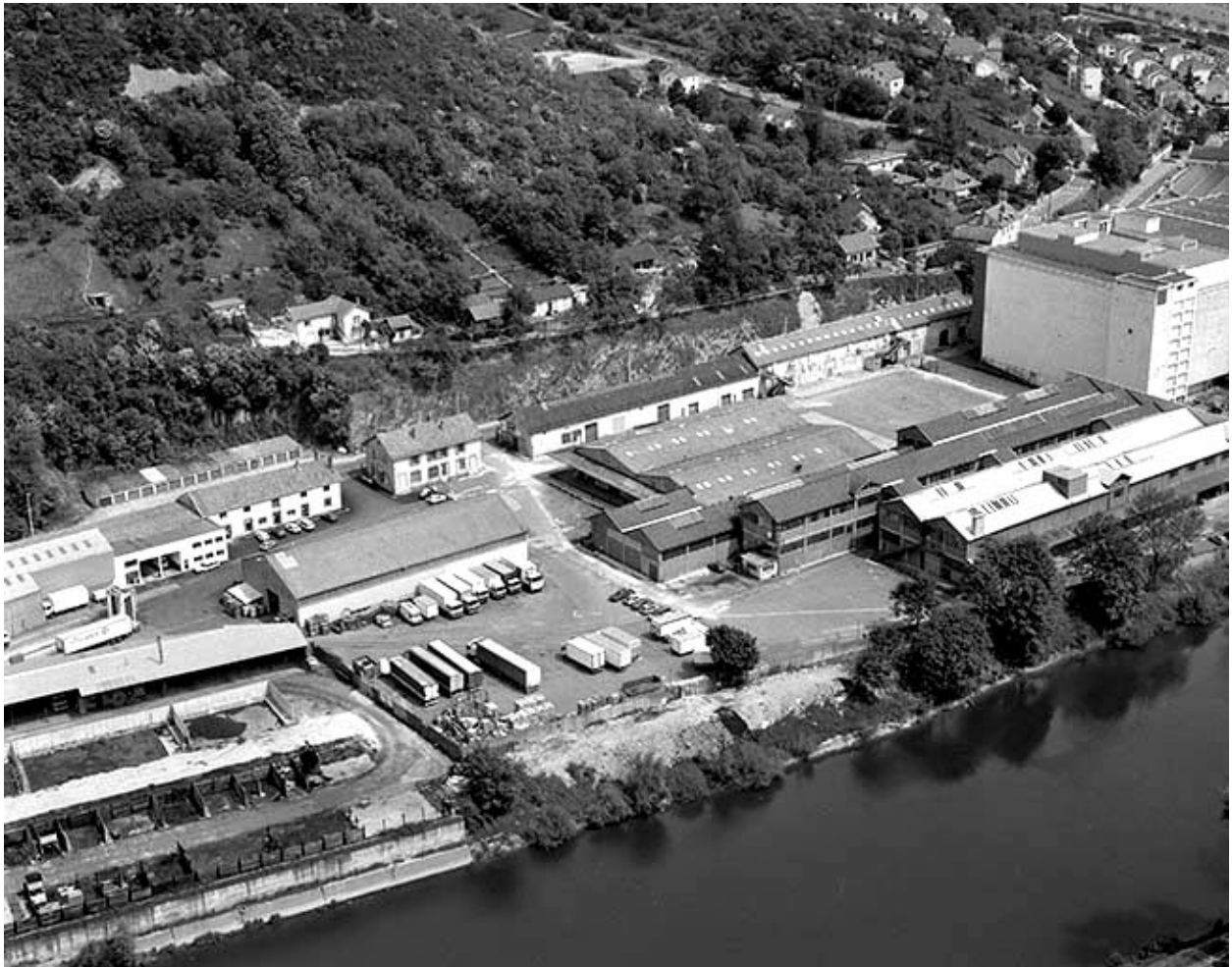
Usine B : bâtiments de l'ancienne papeterie.
