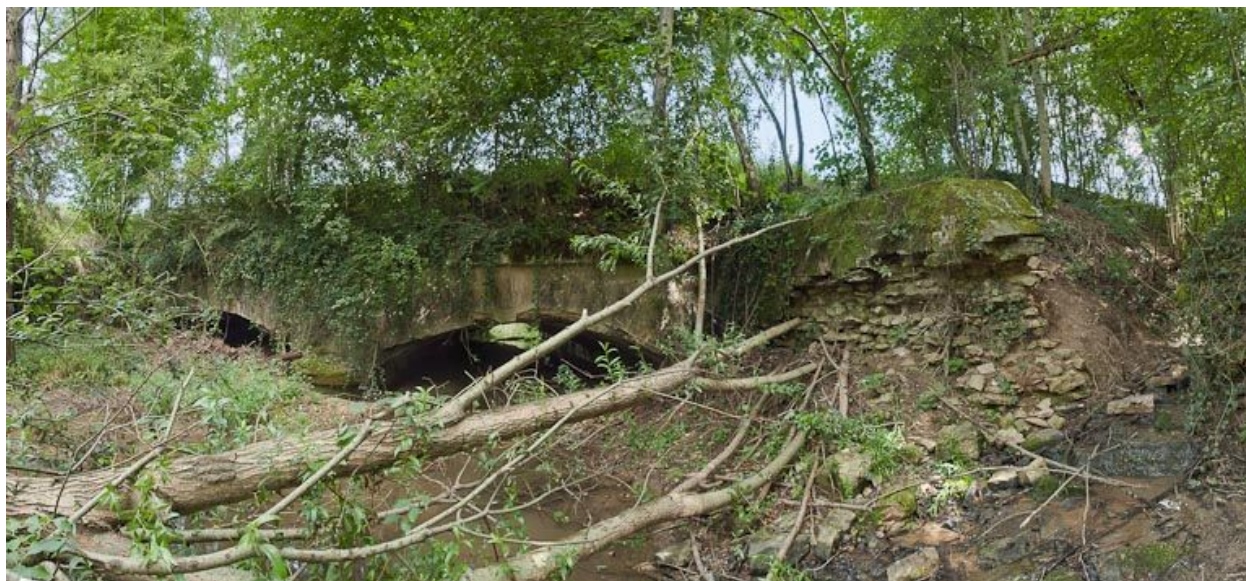
Vue des deux arches de l'aqueduc.
