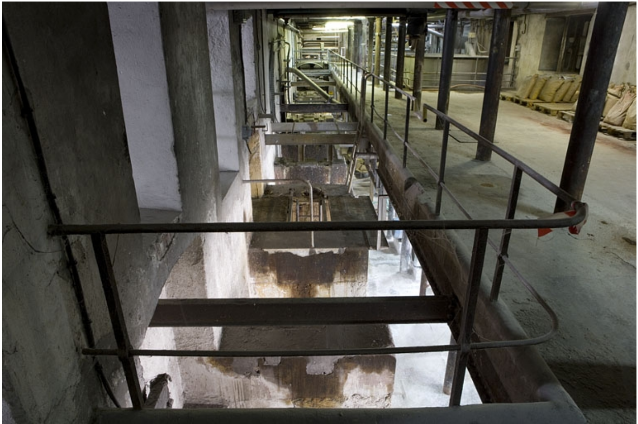
Atelier de fabrication (premier étage). Trémie pour passage de la transmission horizontale vers les pulpeurs.
