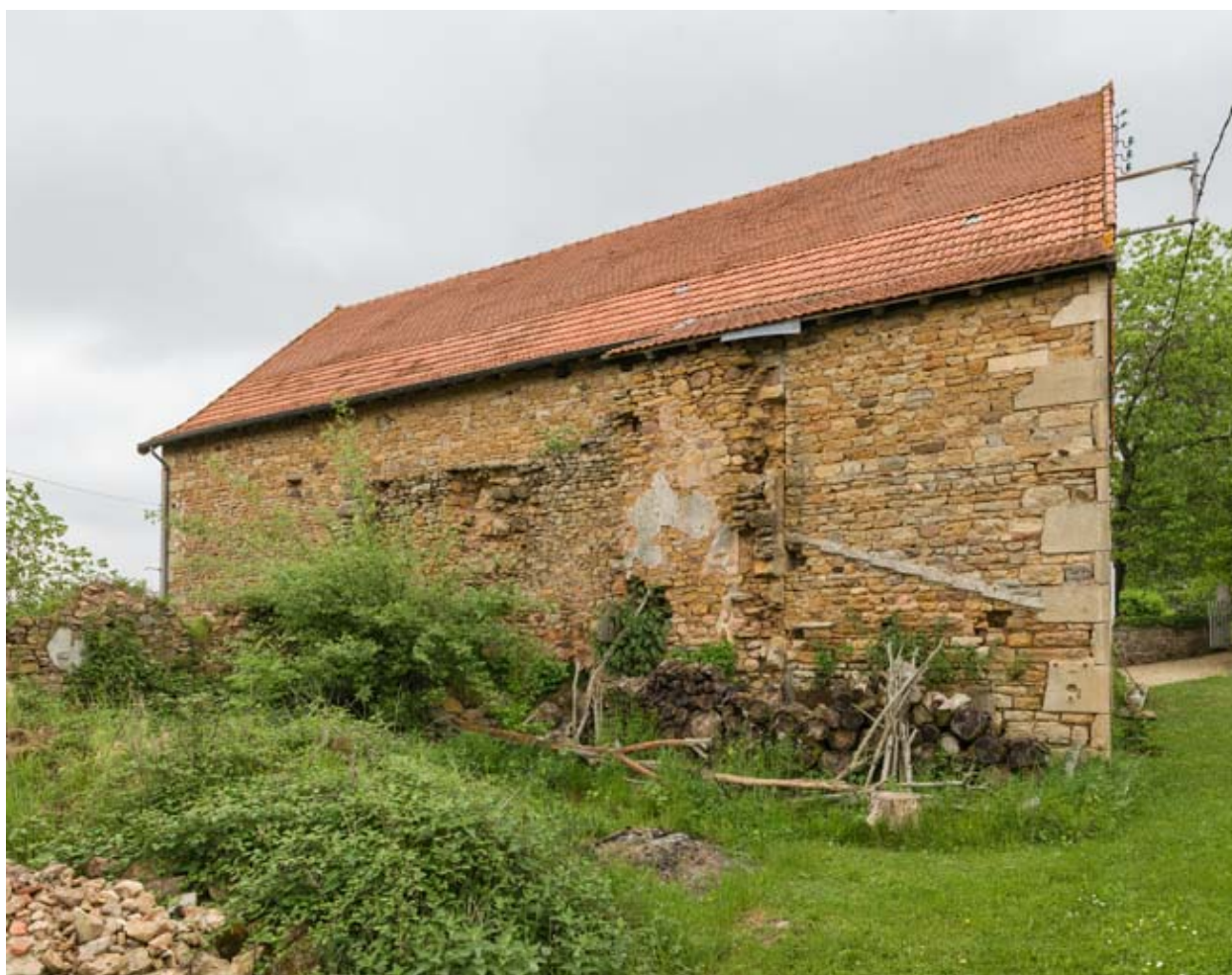
Façade postérieure de l'étable.
