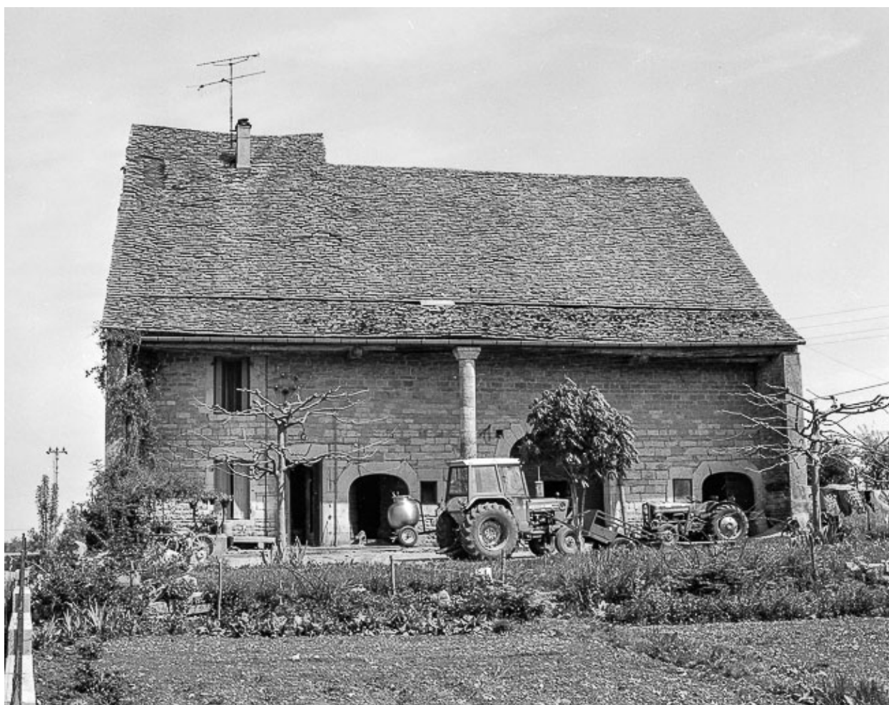
Ferme située le long du chemin de grande communication n° 96 de Plasne à Mirebel..
