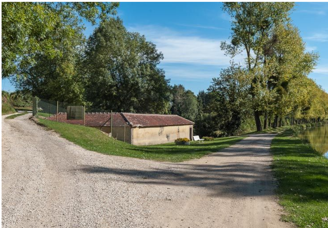
Vue d'ensemble du lavoir.
