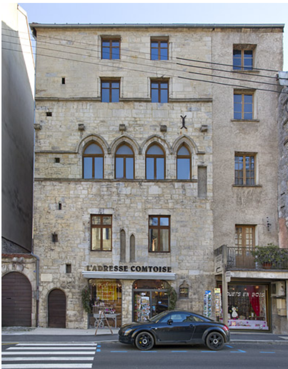
Façade antérieure. Vue de face (2012).
