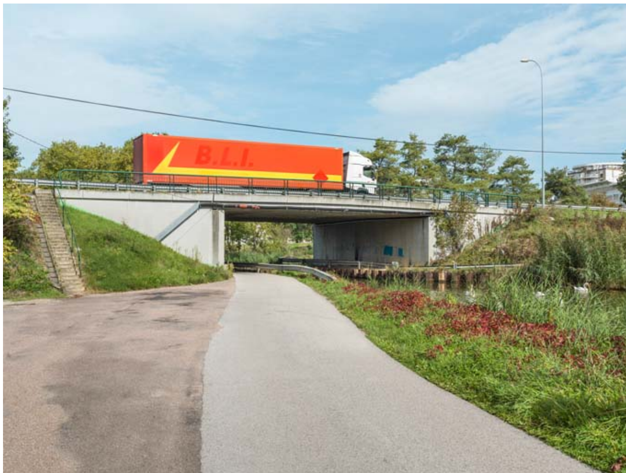
Vue d'ensemble du pont.
