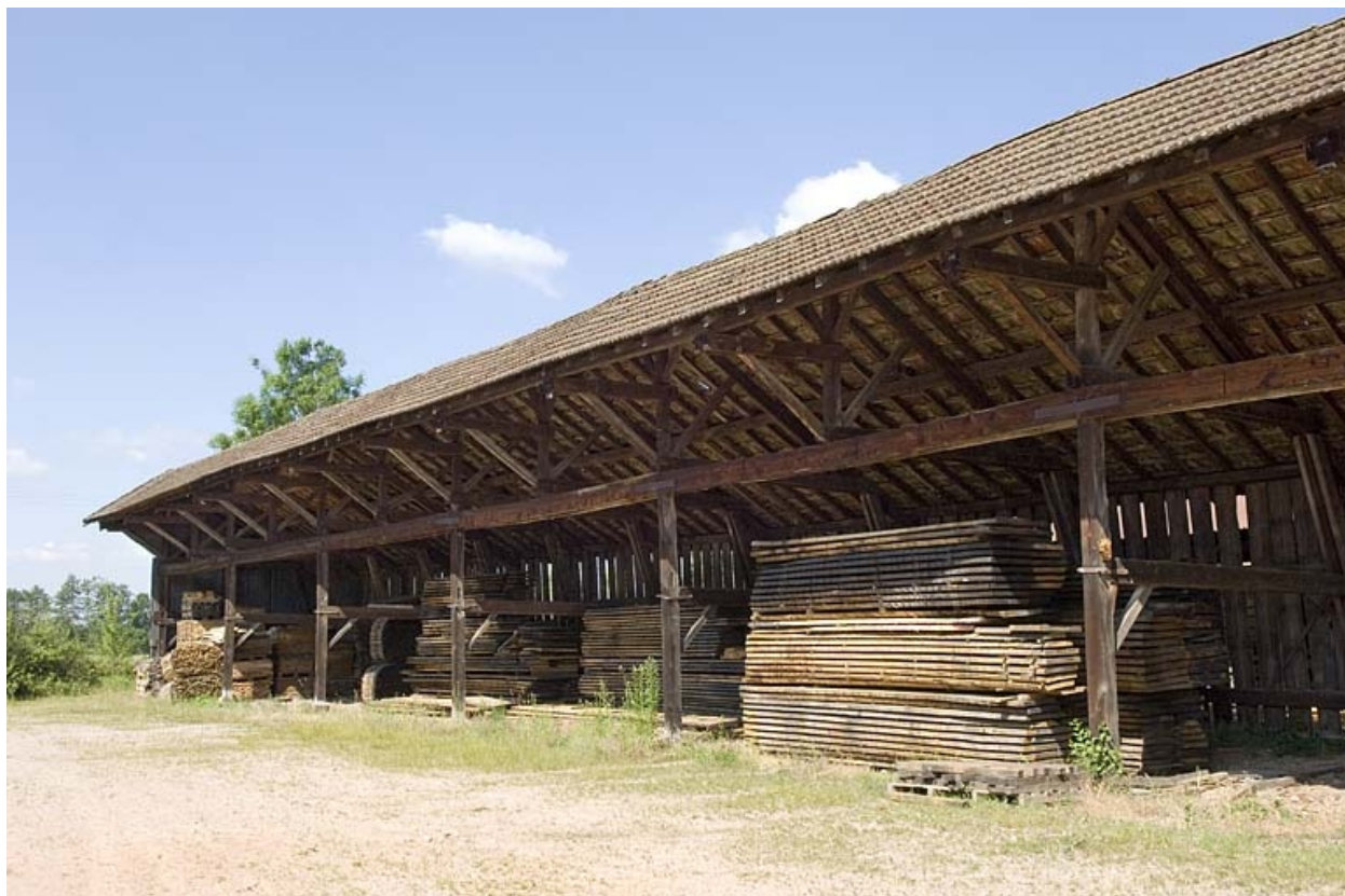
Entrepôt industriel ouest. Vue de trois quarts.
