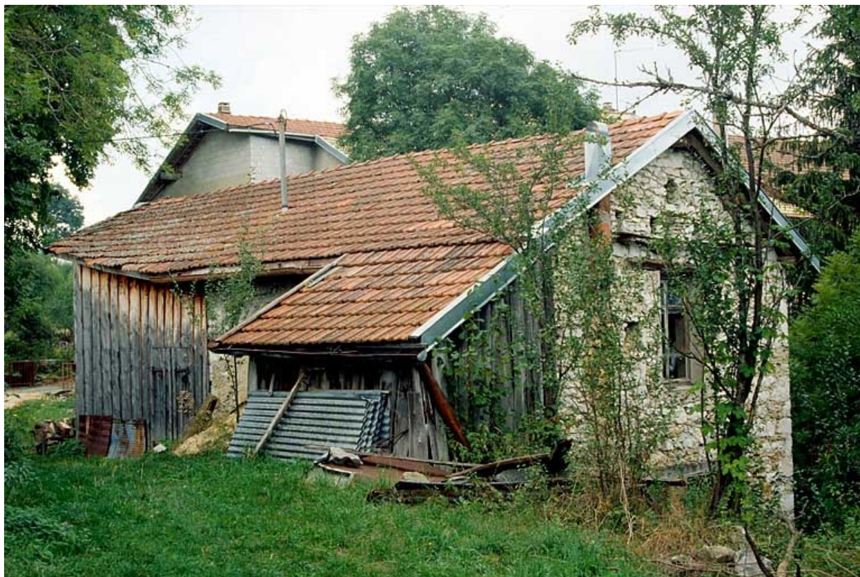
Façades postérieure et latérale droite.
