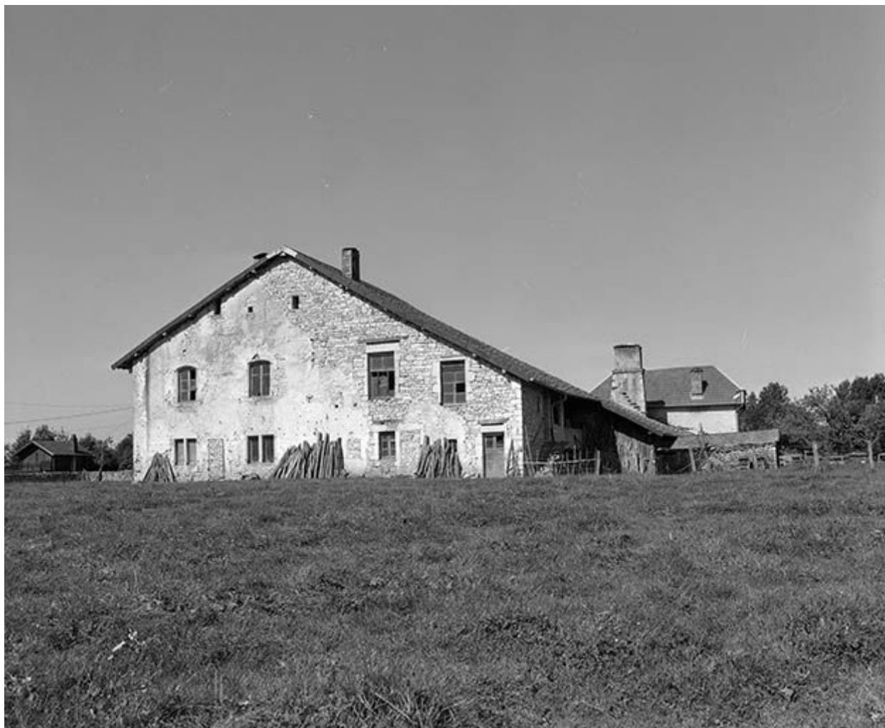
Façade antérieure et face latérale droite.
