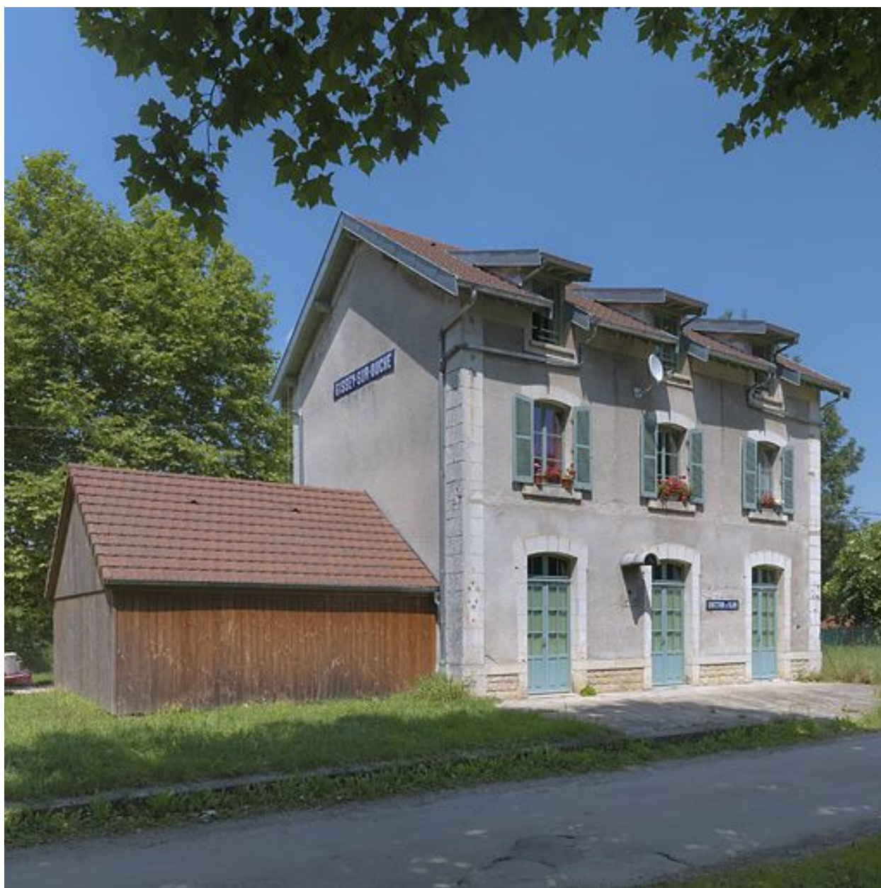
Le bâtiment des voyageurs, 3/4 gauche.
