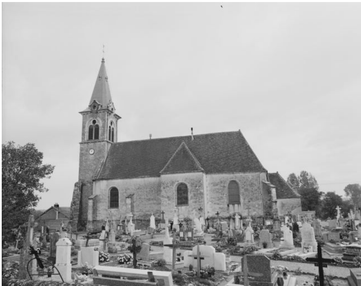
Façade latérale droite.
