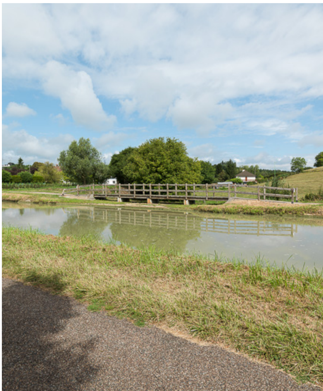
Vue d'ensemble de l'aqueduc.
