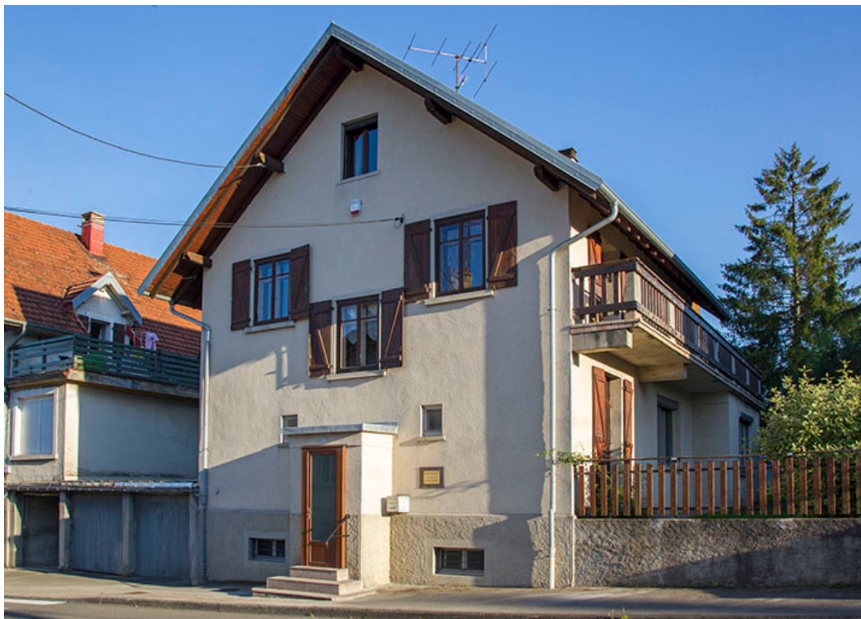
Façades antérieure et latérale droite.
