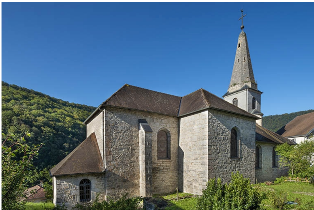
Façade latérale gauche en 2021.
