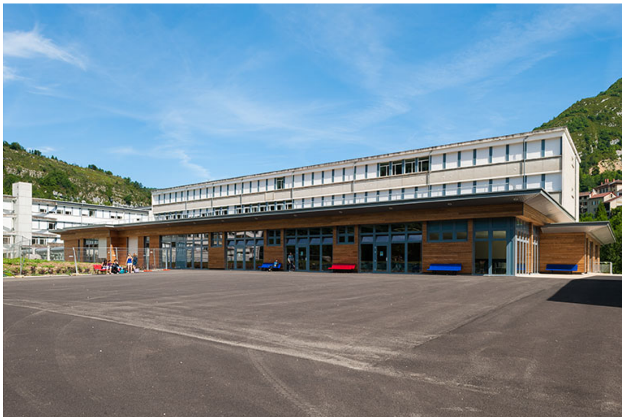
Cour et bâtiments des formations tertiaire.
