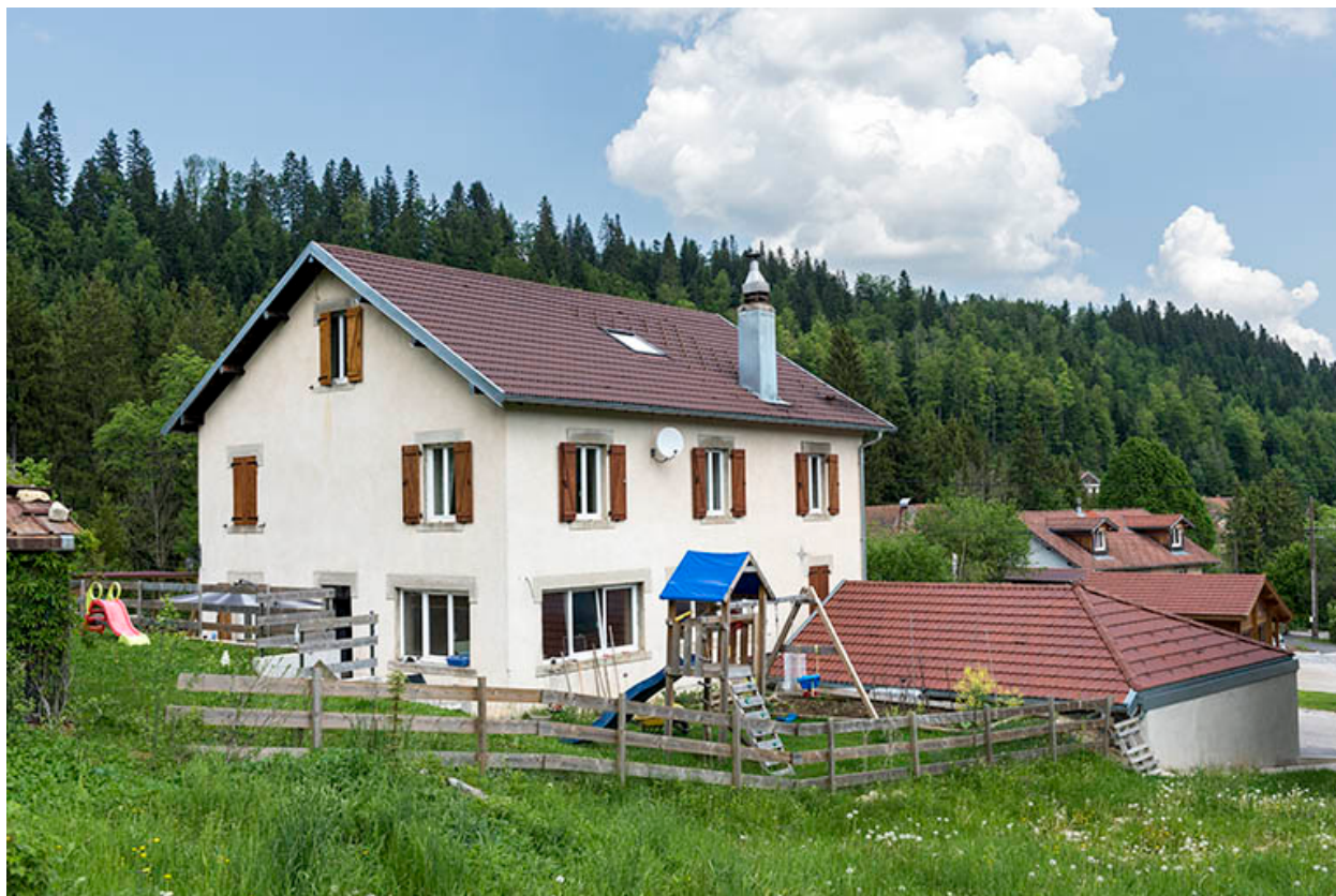
Façades postérieure et latérale gauche.
