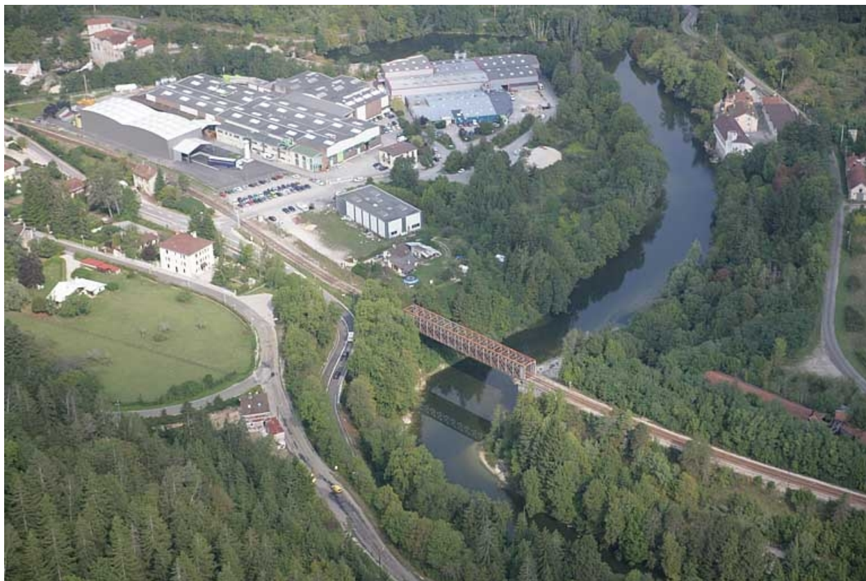
Vue aérienne, depuis le sud-est.
