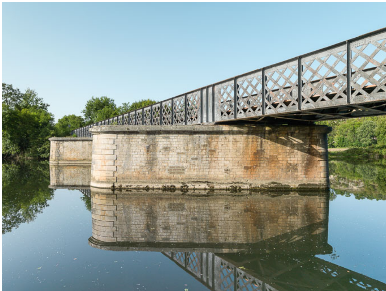
Vue du pont.
