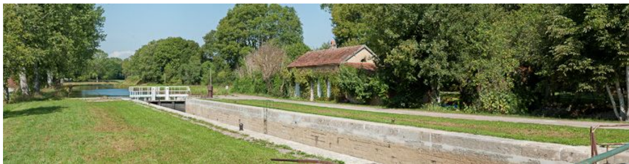
Vue du site d'écluse.
