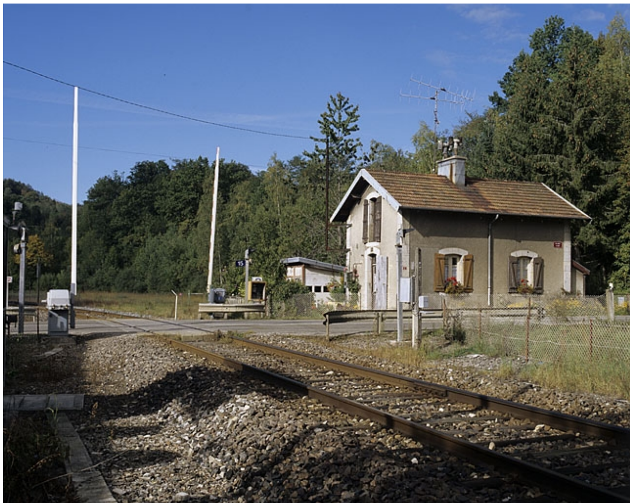
Façades antérieure et latérale droite.
