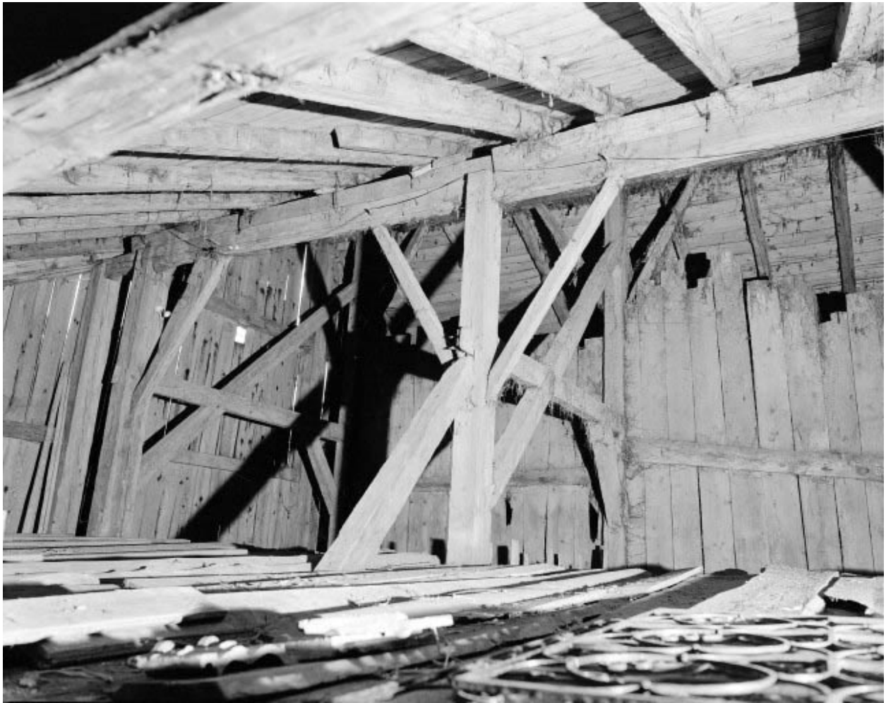
Intérieur en 1977, combles : fermes de charpente postérieures.
