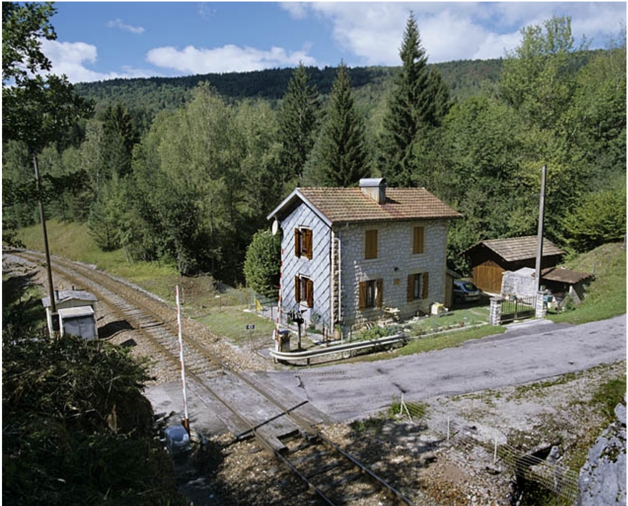
Vue d'ensemble plongeante, depuis le sud-est.
