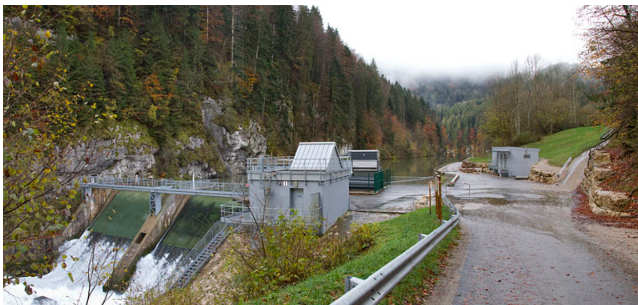
Barrage du Refrain : vue d'ensemble depuis l'aval.
