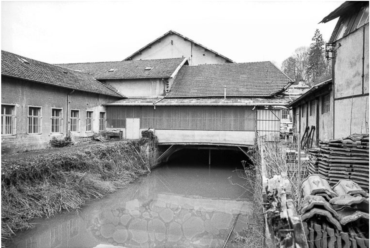
Canal de fuite principal en 1979.
