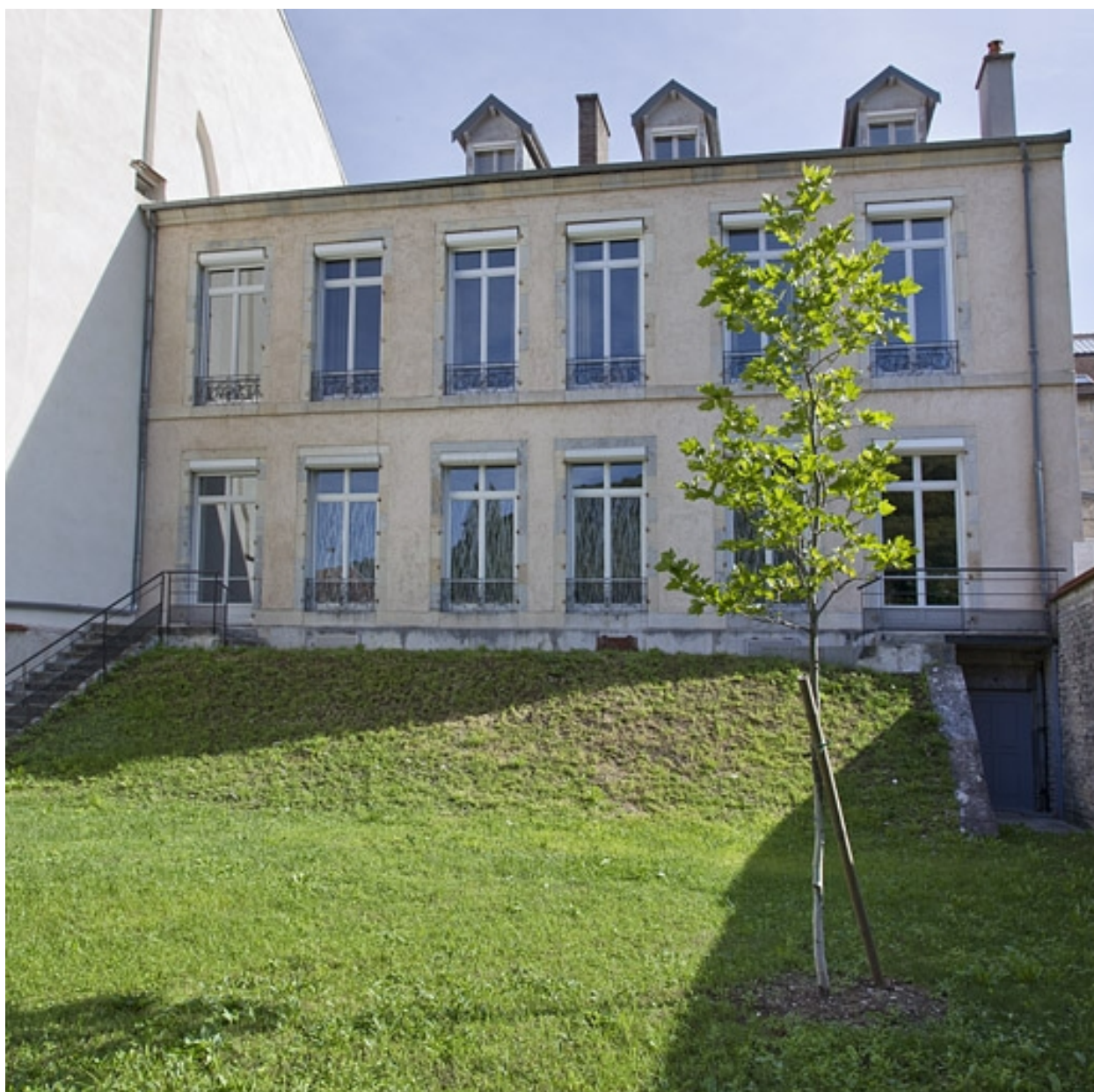
Façade postérieure : de face.
