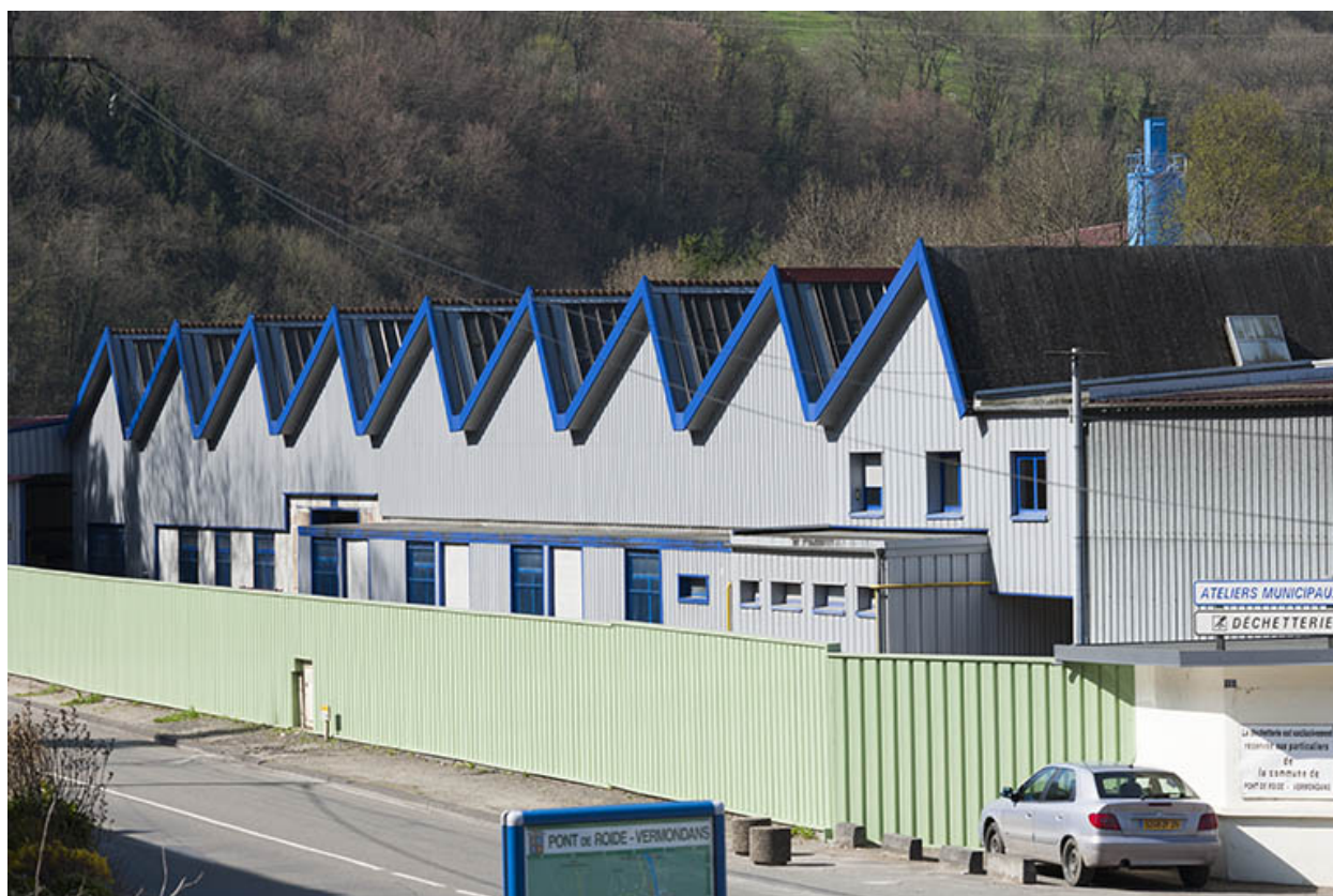
Ateliers sud de la rive droite.
