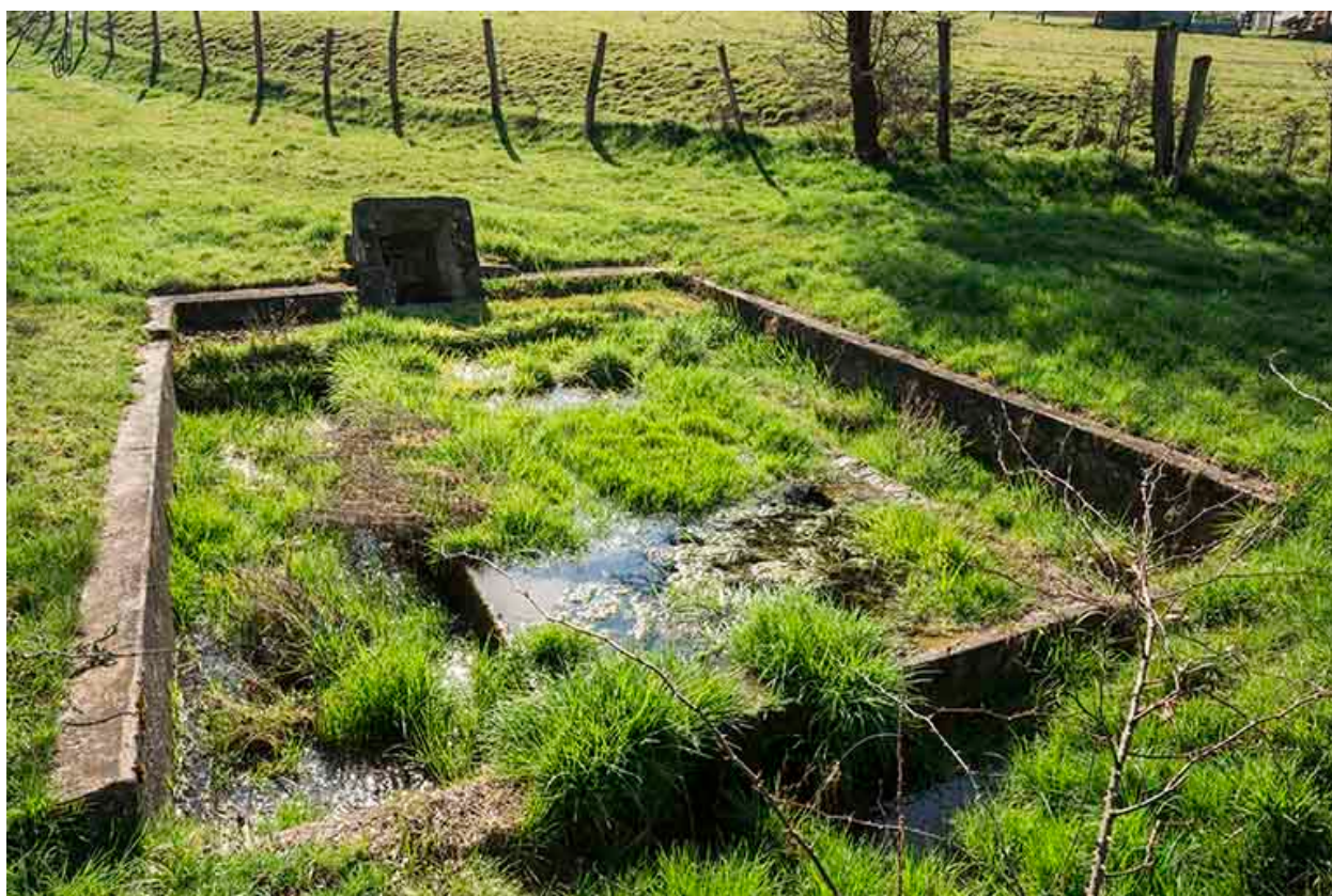
Lavoir, quartier des Graviers.
