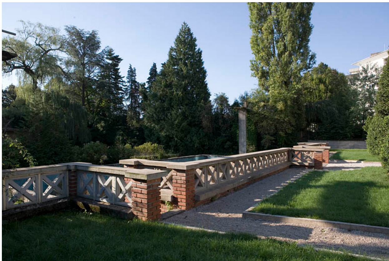
Jardin : garde-corps, du côté de l'usine.
