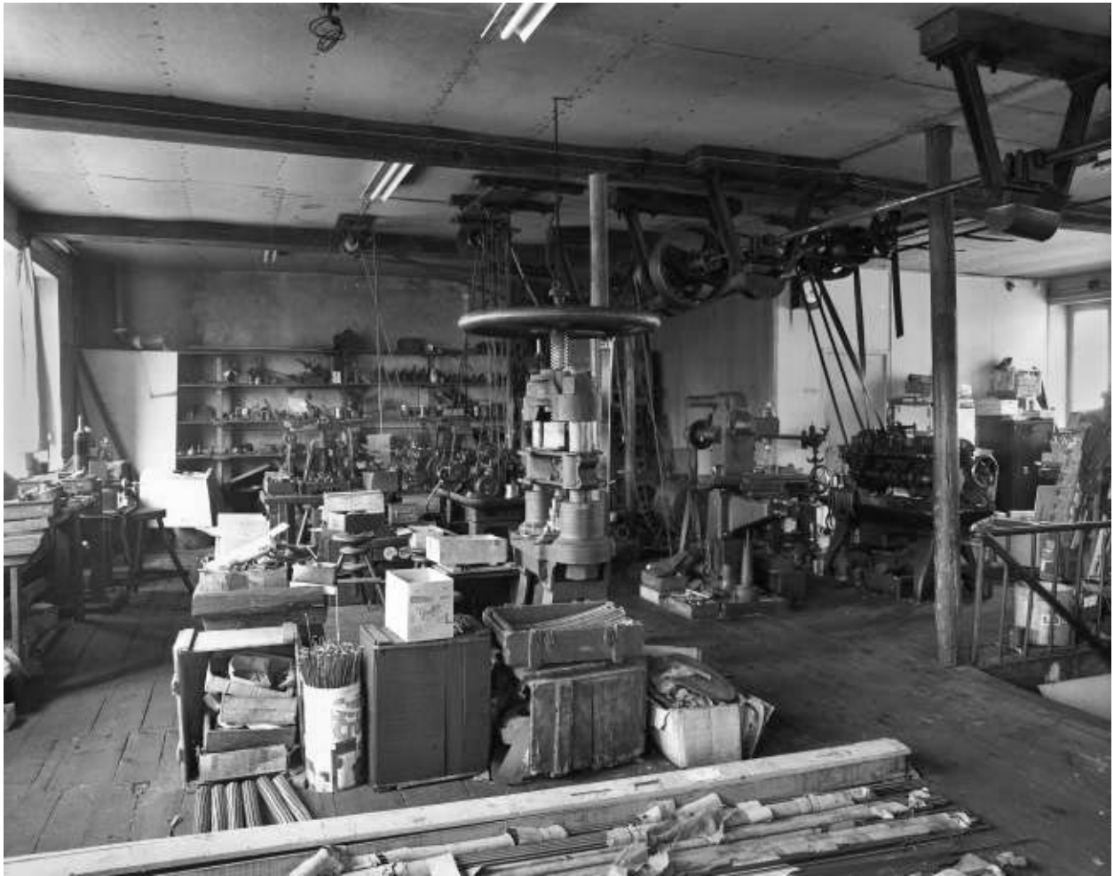
Intérieur de l'atelier à l'étage et machines.
