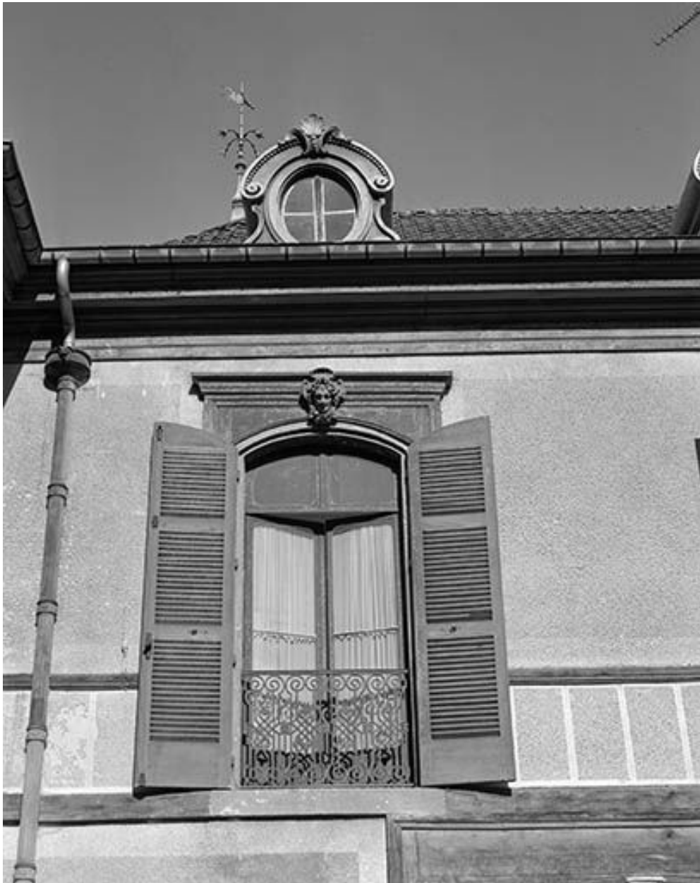
Façade postérieure : une baie du 1er étage.
