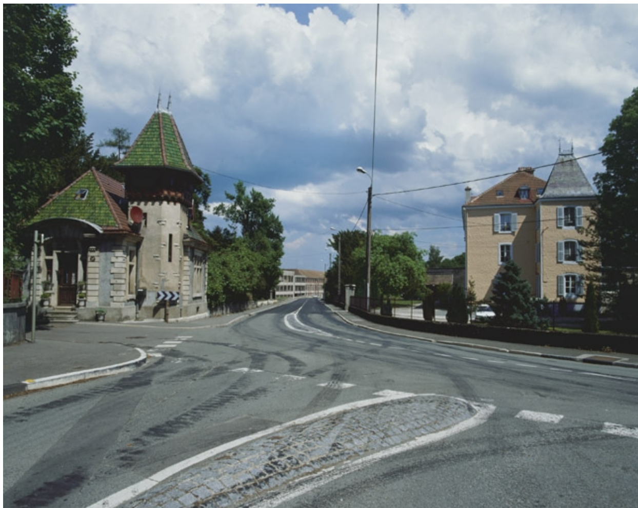
Vue d'ensemble de la conciergerie (à gauche).
