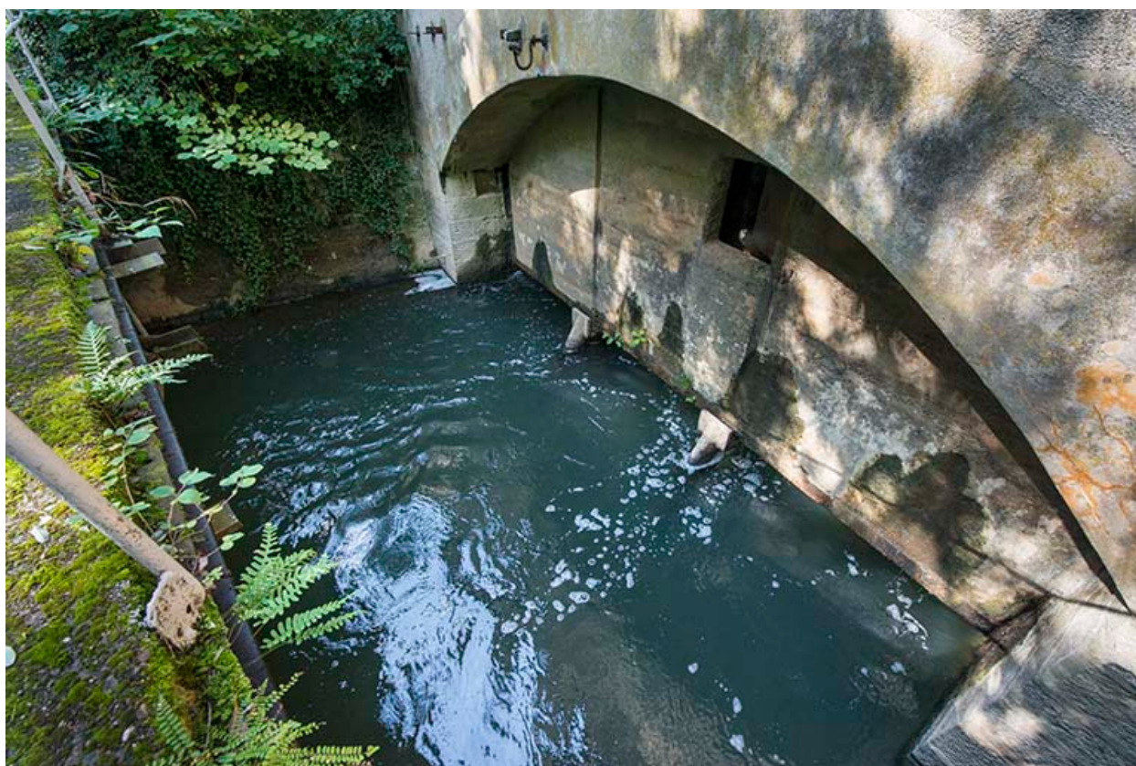
Canal de fuite en sortie de l'atelier.
