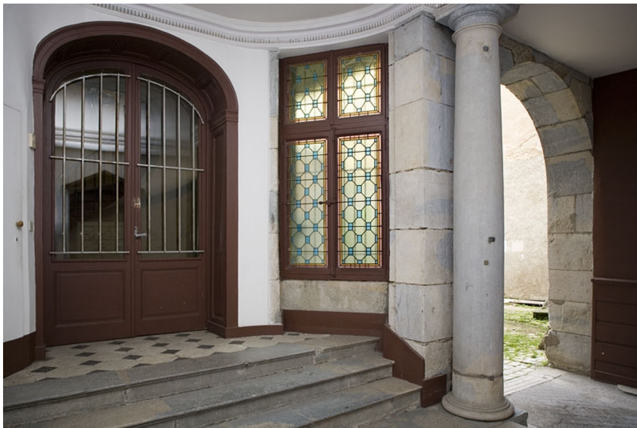
Vue de l'entrée de l'escalier.
